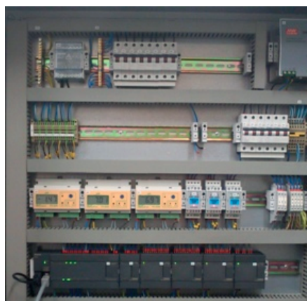
Rysunek 17. Szafa sterująca z sterownikiem PLC
