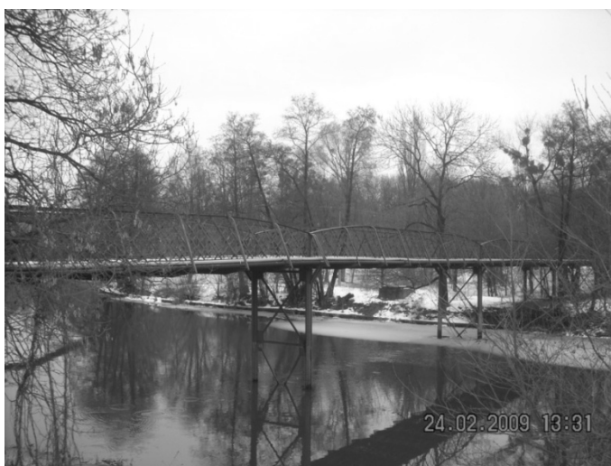
Fot. 2. Kładka Siedlecka. Autor: O. Płachta.
