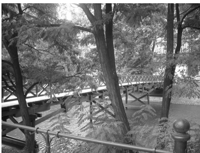
Fot. 3. Kładka św. Antoniego. Autor: O. Płachta.
