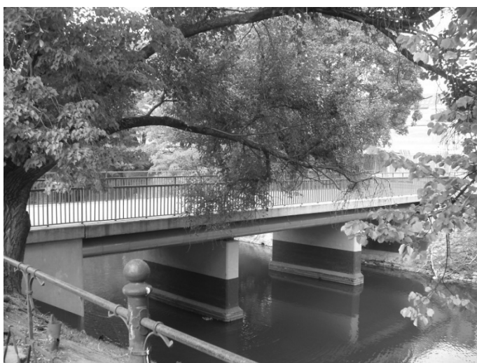
Fot. 3. Kładka Sądowa. Autor: O. Płachta.
