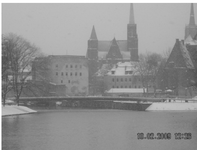
Fot. 8. Kładka Piaskowa. Autor: O. Płachta.
