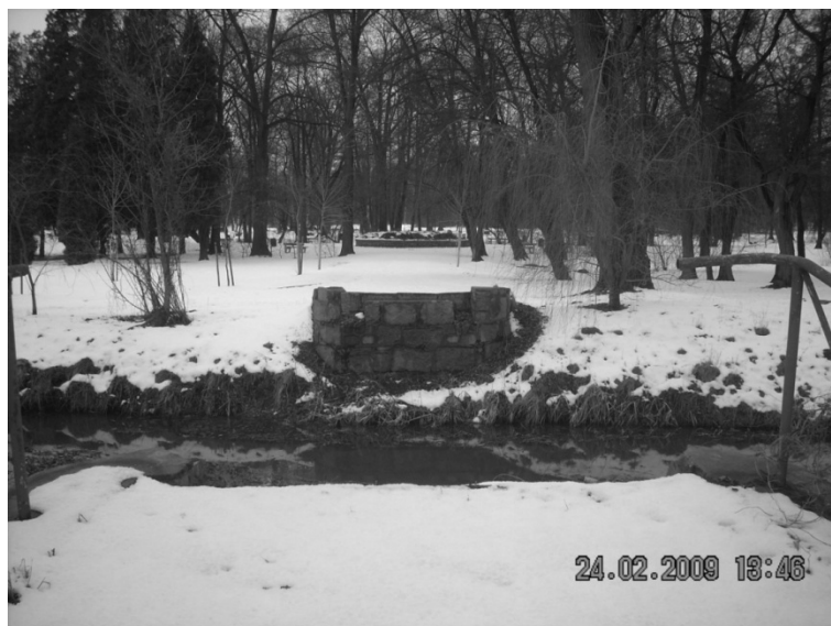
Fot. 6. Pozostałość po nieistniejącej Kładce Parkowej. Autor: O. Płachta.
