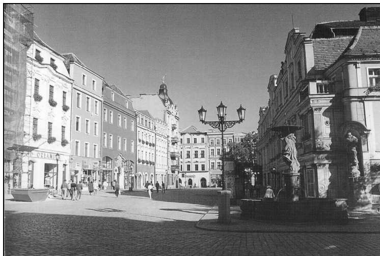
Fot. 5. Rynek w Świdnicy. Kamienice z elementami renesansu i baroku
