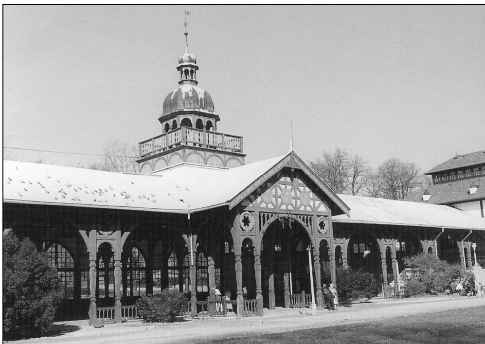
Fot. 21. Szczawno – hala spacerowa przy pijalni wód mineralnych z 1894 r. Źródło: Pilch 2005.
