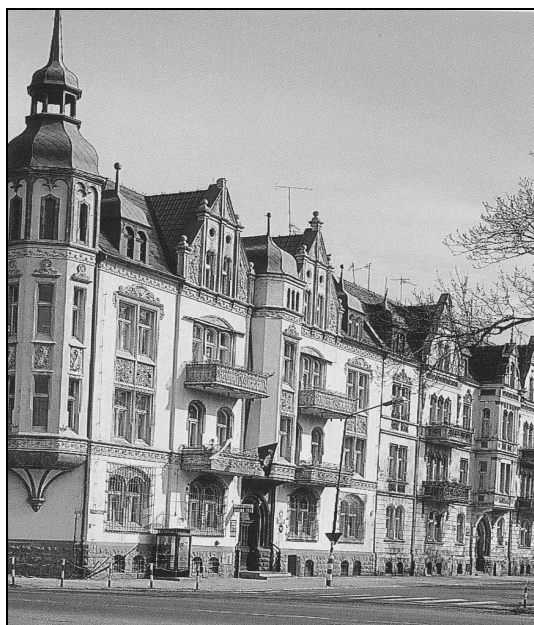
Fot. 7. Budynek poczty w Bolesławcu
