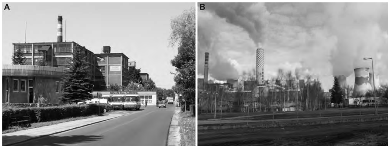
Ryc. 107. Zakłady Obuwnicze Otmęt [A] i Elektrownia Turów w Turoszowie [B].
